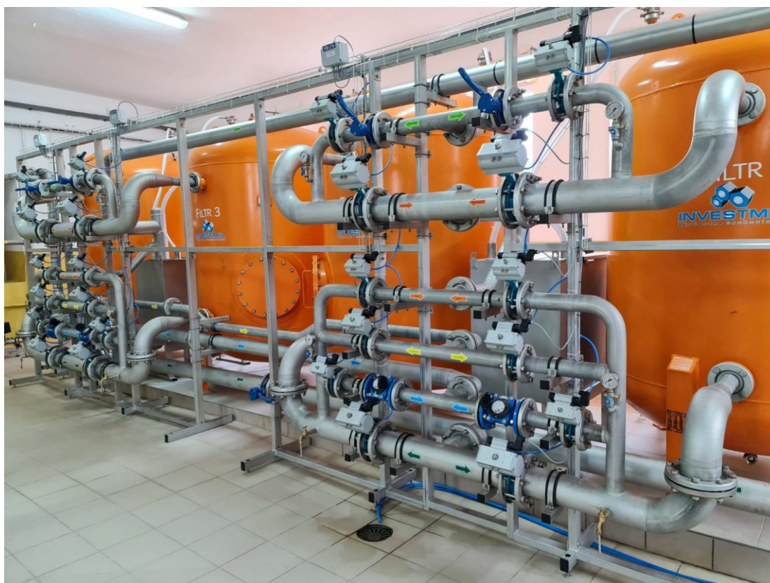
Modernizacja Stacji Uzdatniania Wody w Kodniu
