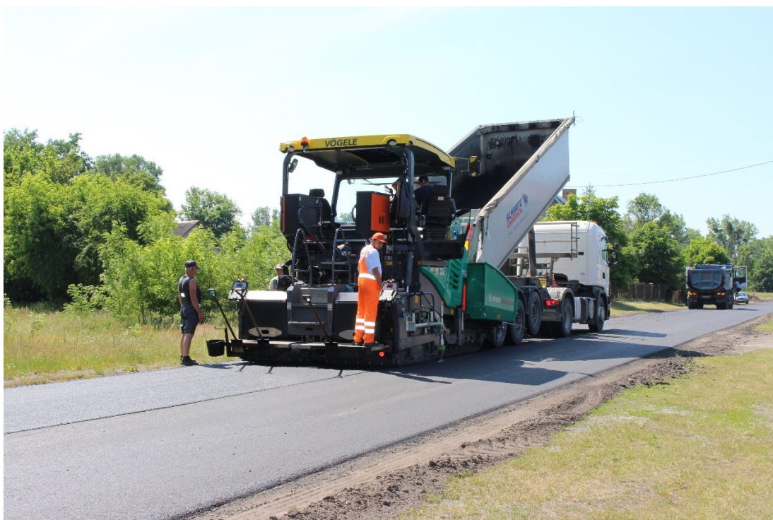
Remont Drogi Wojewódzkiej 816 (Nadbużanka)
